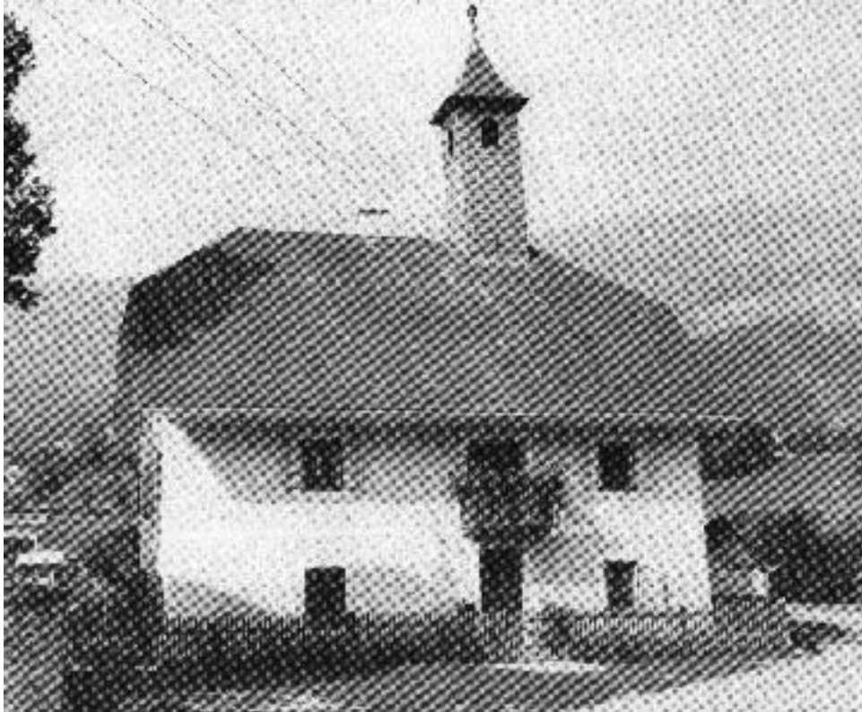
Das alte Pfarrhaus mit Glockenturm
